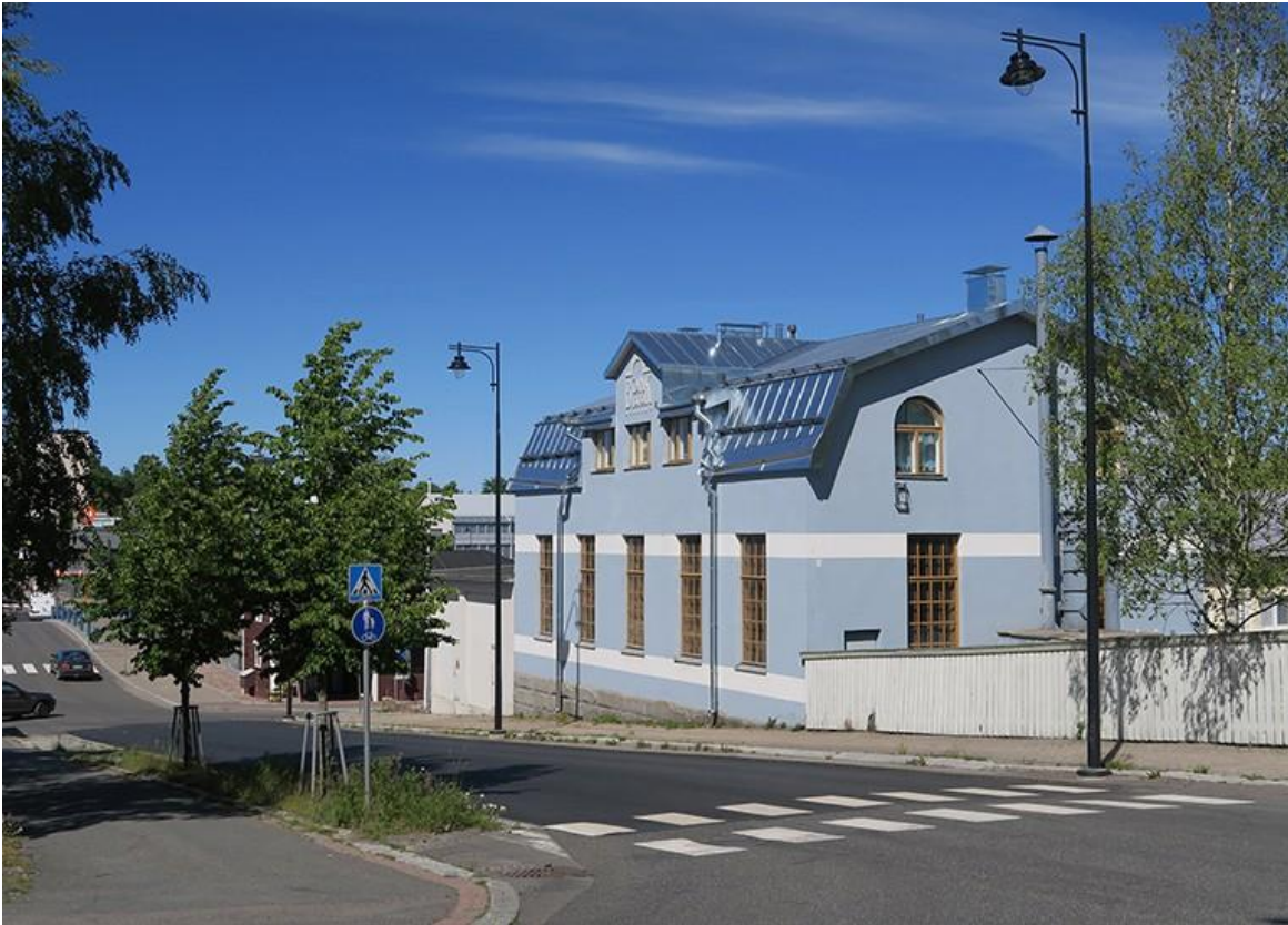
Bonk-museon rakennus kesällä 2019. (Asemakaavamuutokset, kohta 11.)
