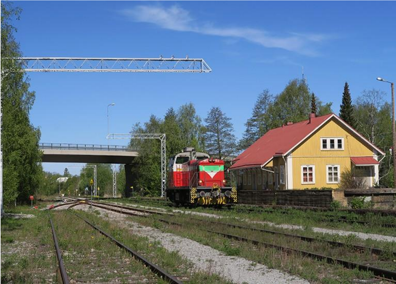
Rautatieaseman ratapihan näkymiä toukokuussa 2020. Asemarakennus on yksityisessä omistuksessa. (Asemakaavat, kohta 2.)
