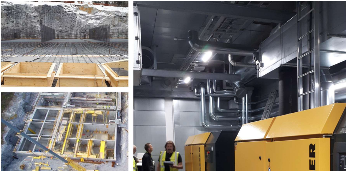
Kuva 3 Saneerauksen vaiheita: Altaiden raudoittamisesta ohjauslaitteiden asennukseen
