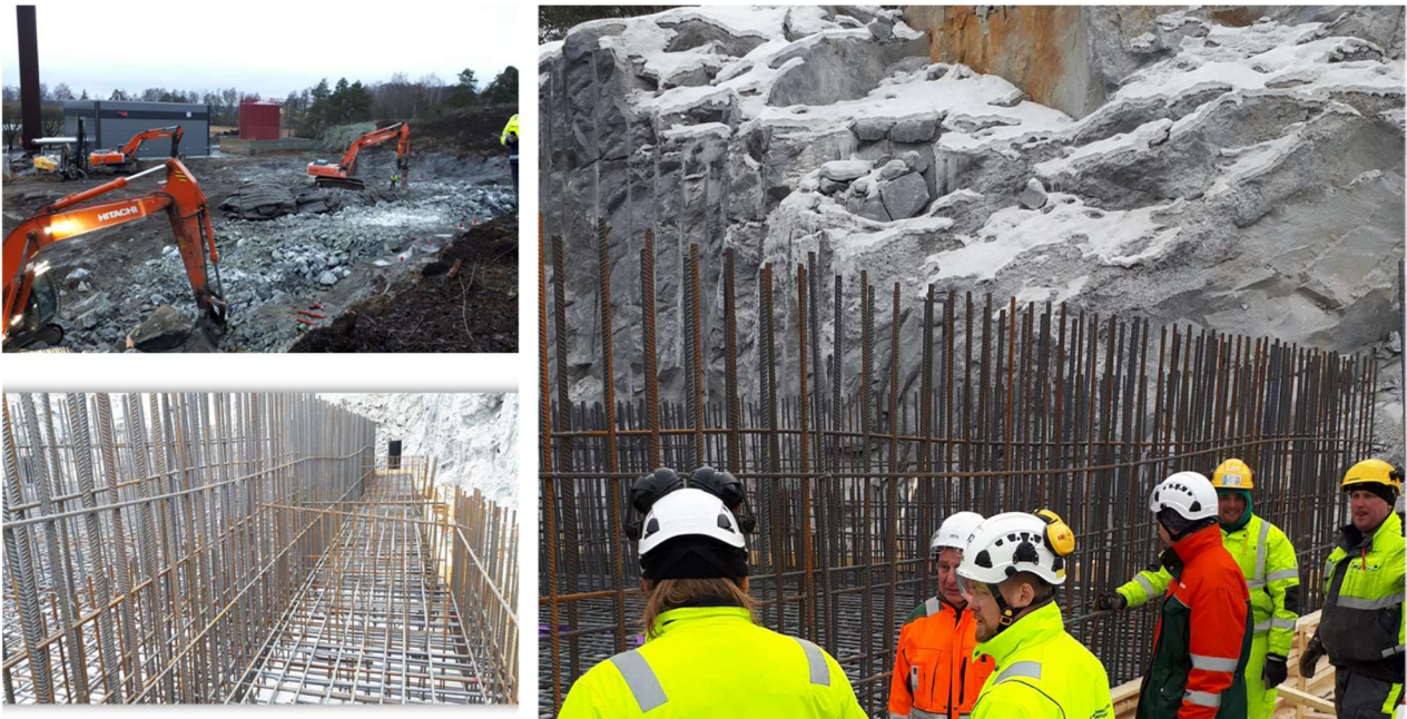
Kuva 4 Saneerauksen eri vaiheita
