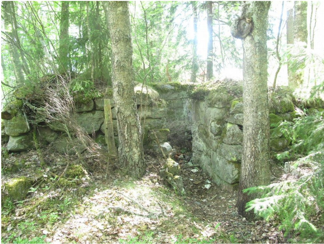
Kuva 18. Vanhan maakellarin jäänteet kohteessa 6. Pohjoiseen.
