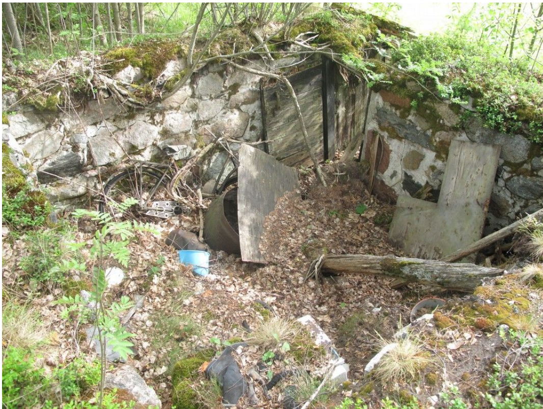
Kuva 15. Vanhan maakellarin jäänteet kohteessa 5. Lounaaseen.
