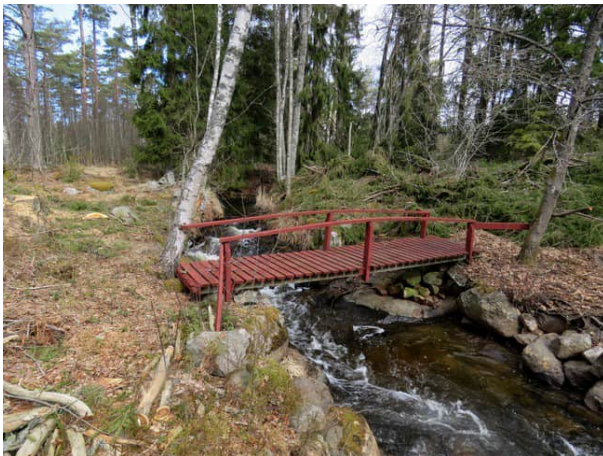
Mylly 4:n perustuksen päällä on tehty puinen silta.
