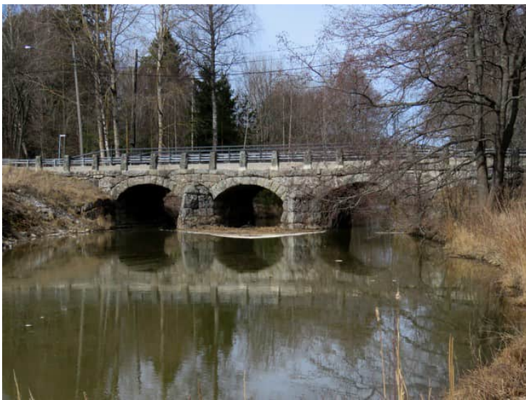
Silta kuvattu luoteeseen.
