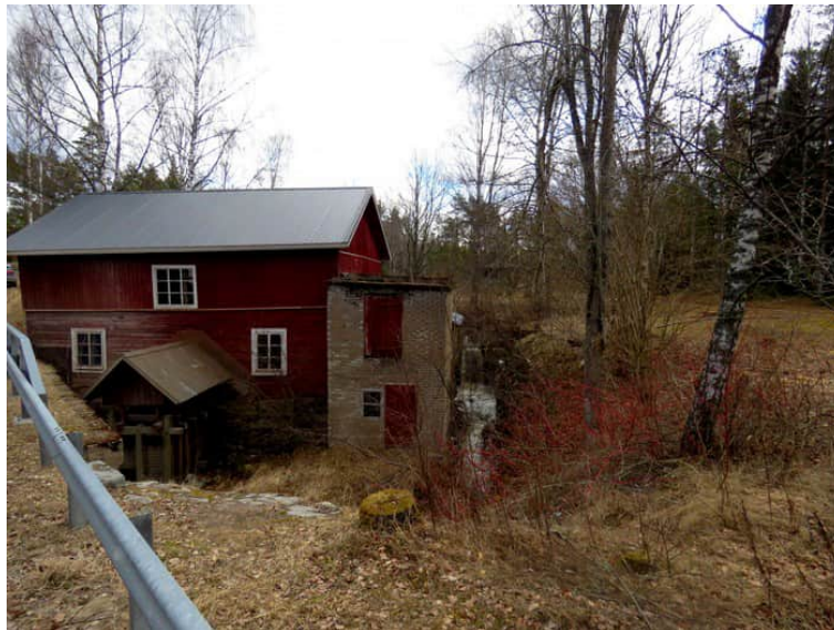
Myllyrakennus kuvattu maantiesillalta koilliseen.
