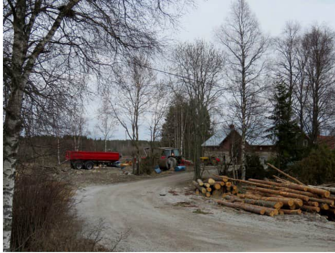
Pietilän uusi talusrakennus ja tasoitettu piha-alue.
