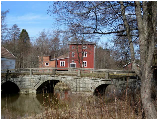
Männäistenkosken silta ja ruukki pohjoiseen.
