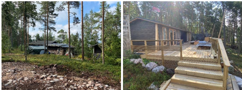
Talousrakennuksia korttelin 4 rakennuspaikalla 1.
