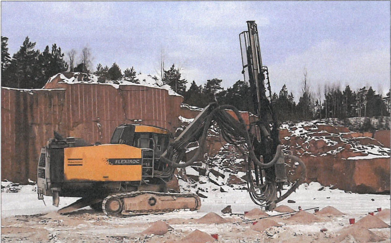
Kuva 3. Ympäristömelumittausten aikana porattiin kalliota.
