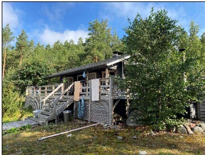
Saunarakennus korttelin 4 rakennuspaikalla 1.
